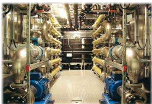
Рисунок 11. Установка ультрафильтрации трубчатого типа
