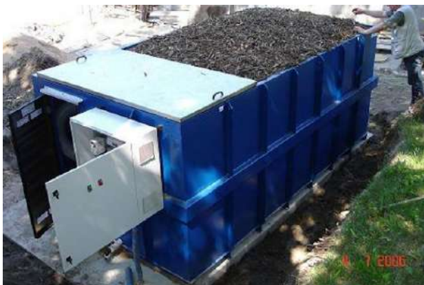
Рисунок 14 Биологический фильтр в сборе
